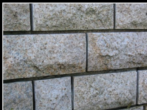
SM PL 005 Revestimento em granito amarelo escasselhado
