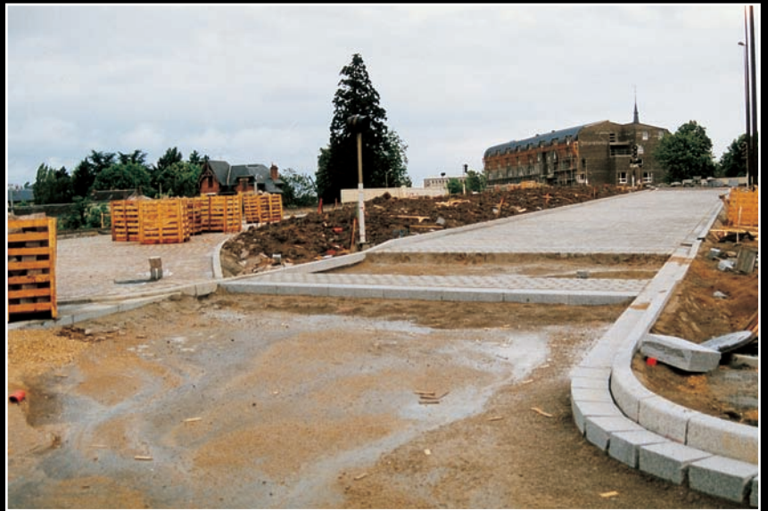
SM PA 030 - Construção em granito
