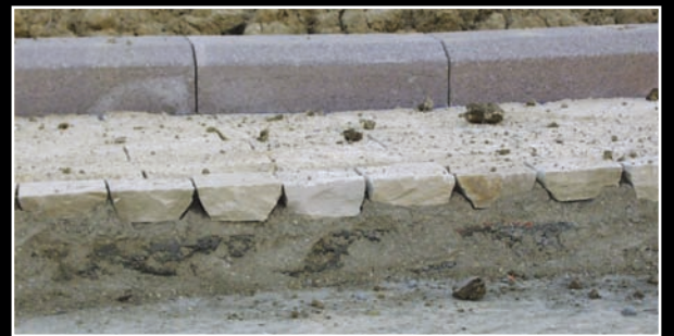
SM RE 008 - Assentamento de cubos em chapa de cimento
