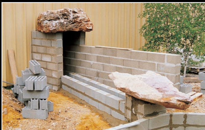
DC RE 007 - Construção de uma cascata
