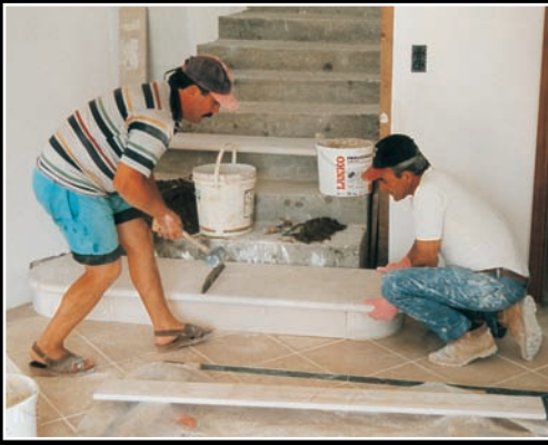
SM DS 026 Revestimento em calcário de escadas interiores
